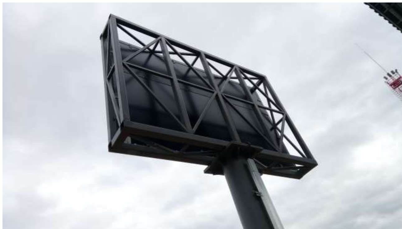
Московская обл., Табло электронной очереди для НС Нагорная, Транснефть, 5 шт. по 6,7 м 2
